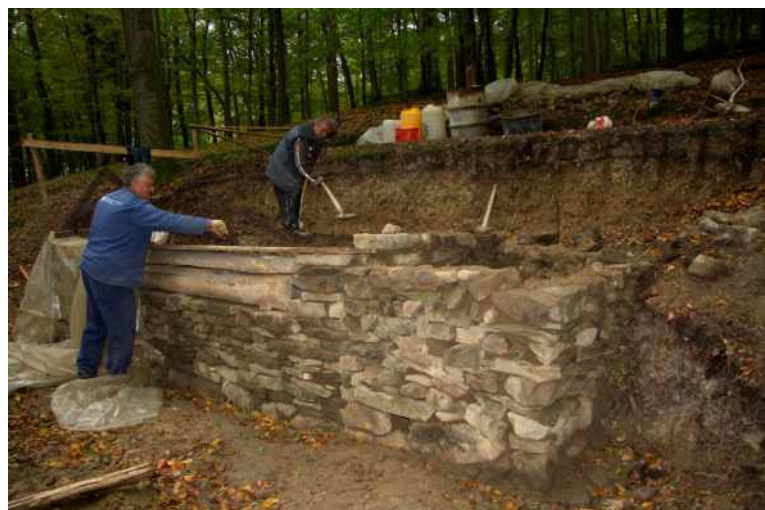
■ Zdění základů horského chléva zpod Babínku ve VMP
