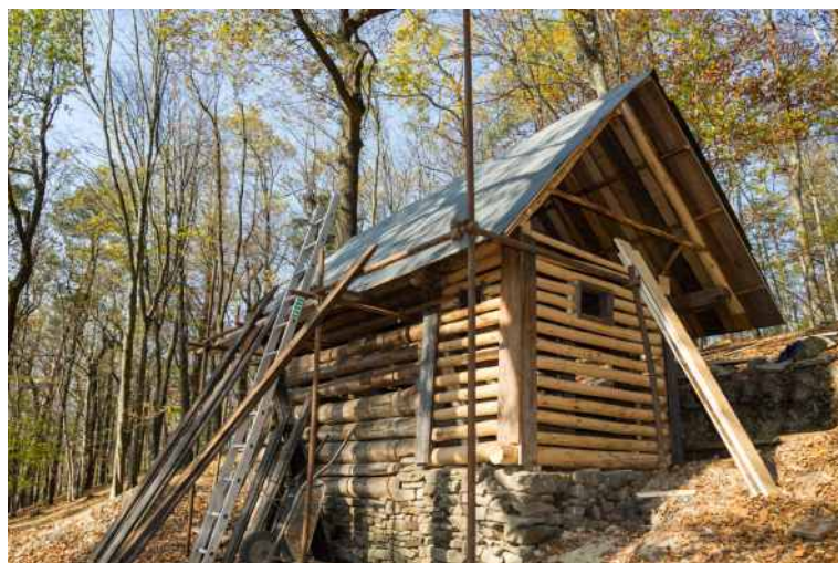
Transfer prvních objektů do nového areálu
