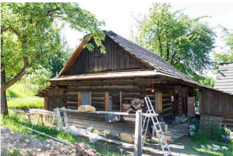
■ Oprava domu chalupníka z Valašské Polanky
