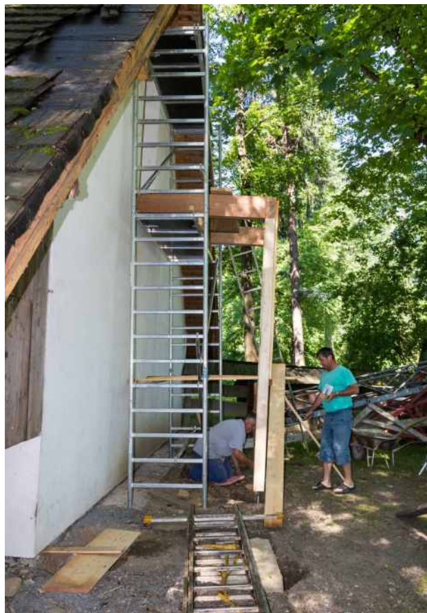
■ Úprava provozní budovy v Dřevěném městečku
