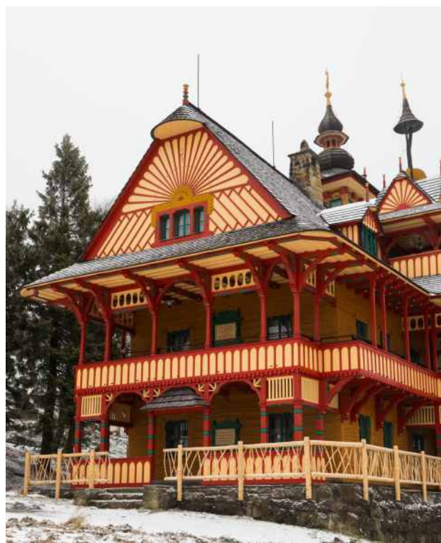
■ Maměnka na Pustevnách po rekonstrukci
