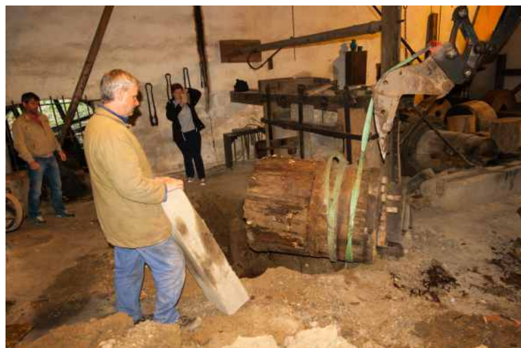
■ Výměna dubových špalků v hamru
